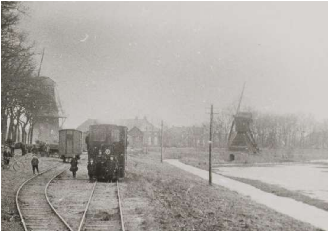
Foto rond 1910 met rechts de spinnenkopmolen die het water uit de polder Hoorn Zuidkant uitmaalde op de boezem van de Westerwoldsche Aa. Links staat de korenmolen Hindrichs en in het midden een stoomtram van de Oost Groninger tramwegmaatschappij, bij het overlaadstation Wedde.
