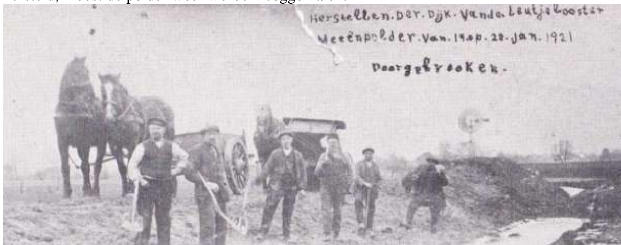
Foto uit 1921 gemaakt door de heer Snelter van de dijkherstelwerkzaamheden na een doorbraak van de Westerwoldsche Aa bij de Lutjelooster Meeënpolder. Waarschijnlijk is de roosmolen op de achtergrond de windmolen van de polder. Van links naar rechts; landbouwer H. Koning uit Hoorn, W. Fens, J. Koning, landbouwer-kastelein J. Velema, molenaar H. Wilts en G. Wilts.
